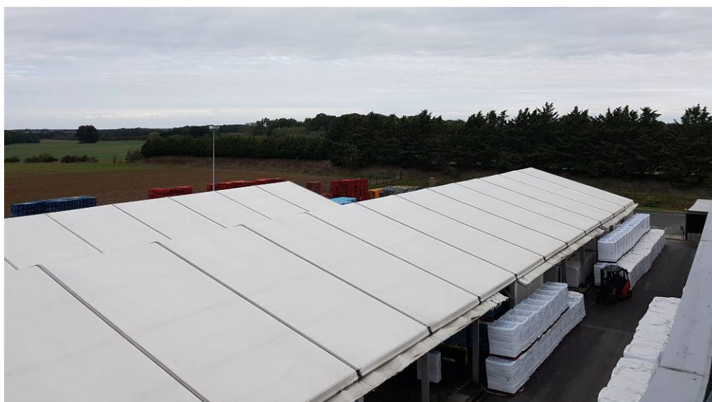
Cliché photographique pris en toiture limite Ouest
