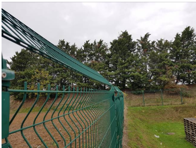
Cliché photographique prise sur la limite Ouest au niveau de la clôture
